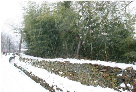
(그림 2) 대나무와 배수로를 활용해서 내부 공간을 보호한 외암리 감찰덕
